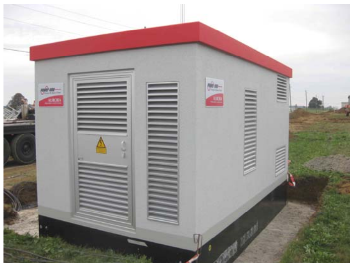
Abb. 4: Beispiel einer Trafostation
