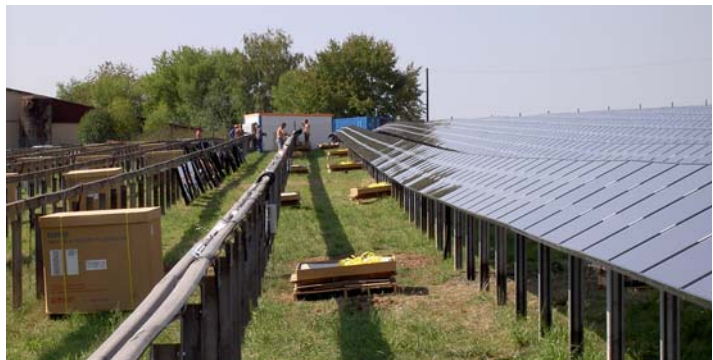
Abb. 3: Beispiel einer Freiflächen-Solaranlage während der Montage
